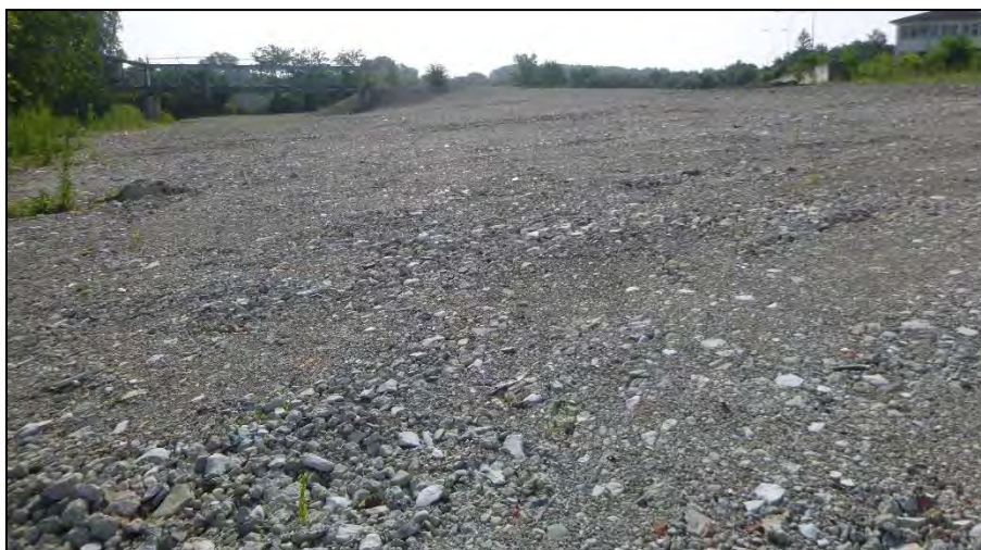
Emplacement des bâtiments détruits ©ETEN Environnement
